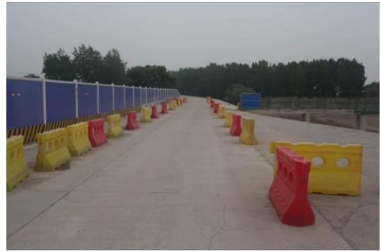
施工临时拦挡
