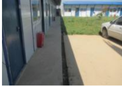
项目部排水沟
