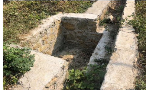
排水沟及沉砂池
